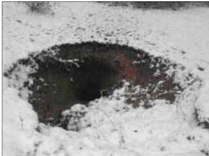
Figure 17 : Effondrement d'une zone sous-cavée par suffosion [Source : BRGM]
