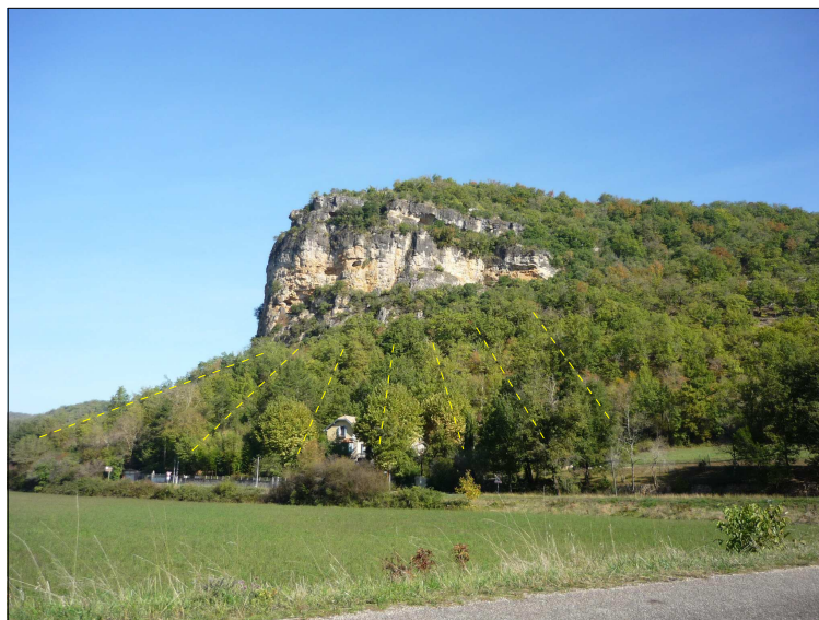
Figure 32 : Grand escarpement calcaire et tablier d'éboulis végétalisé en pied à la confluence entre la Vère et l'Aveyron [Source : IMS RN ]
