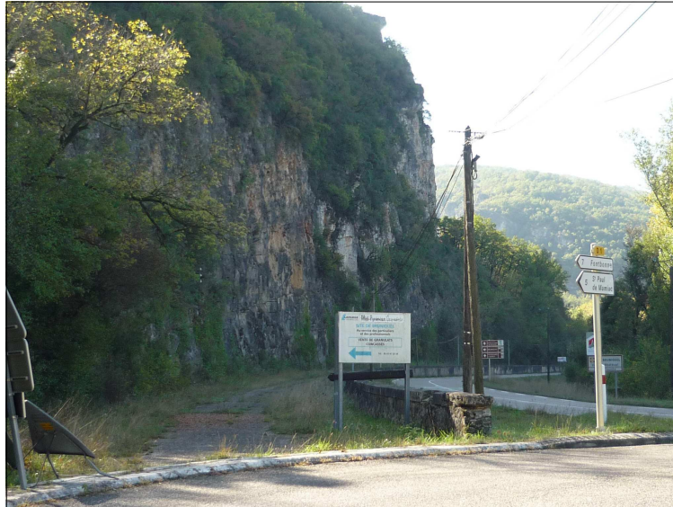
Figure 46 : « Piège à blocs » le long de la RD 115 [Source : IMS rw ]
